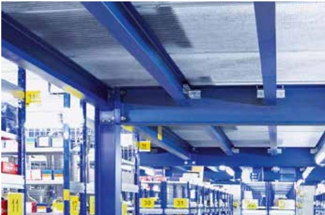
Mit der Lagerbühne aus warmgewalzten Profilen werden hohe  $m^2$ -Belastungen aufgenommen und grosse Spannweiten überspannt. Durch die an den Profilen und Bühnenstützen angeschweissten Flanschplatten wird beim Verschrauben eine sehr hohe Biegesteifigkeit erreicht, weshalb die manchmal störenden Diagonalverbände grösstenteils weggelassen werden können.
