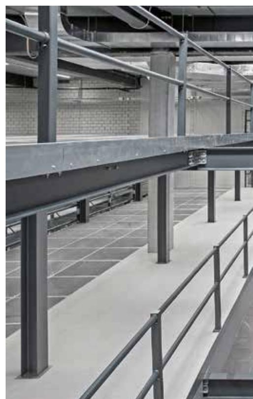
4 - 7 Lagerbühne mit warmgewalzten IPE-Profilen, 3-geschossig, mit Lichtschacht durch alle Ebenen. Abdeckung gemischt mit Spanplatten und Gitterrost, je nach Bedarf. Die Lagerbühne wird mit freistehenden Regalen sowie einer 3-geschossigen Fachbodenregalanlage ergänzt. Die fest im Gebäude eingebaute Liftanlage wird durch die Lagerbühne auf allen Lagerebenen erschlossen.
